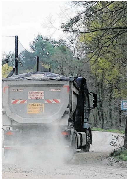
Eine Lkw-Ladung nach der anderen bringt neue Erde an den Golfplatz.
