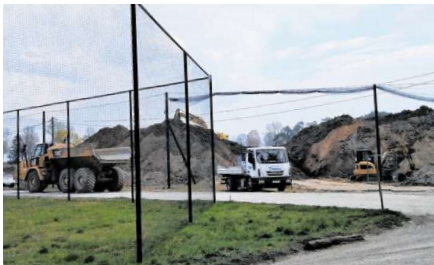
Im Bereich der neuen Driving Range des Golfplatzes wird derzeit unbelasteter Boden eingebracht, um das Gelände golfspezifisch zu modellieren. BILDER: WIDRAT (2)/ZETSC
