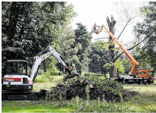
Die Mitarbeiter der Firma Gredler sind im Einsatz – auch in luftigen Höhen. Denn wo die Verkehrssicherheit nicht gefährdet ist, werden die Bäume erhalten.
